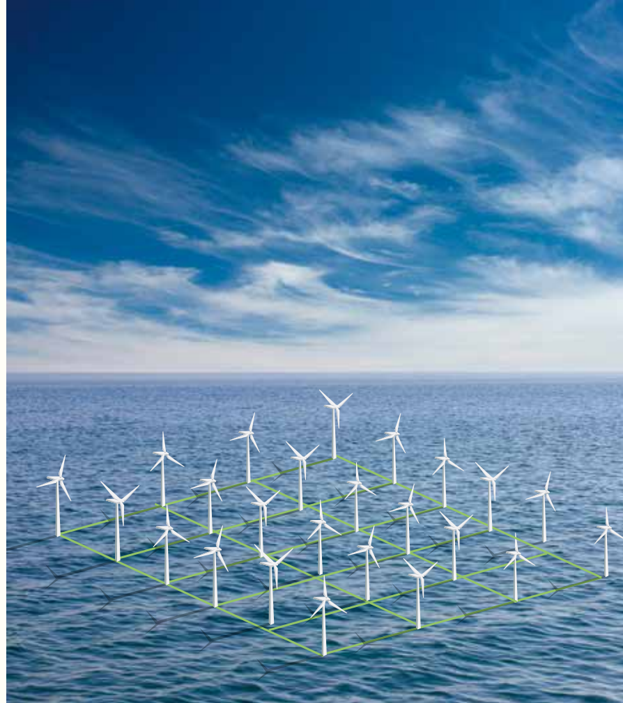
RUTENETT: Vindturbinene plasseres ofte i et rutenett. Med den nye metoden kan man raskt beregne energiproduksjonen for ulike plasseringer.
