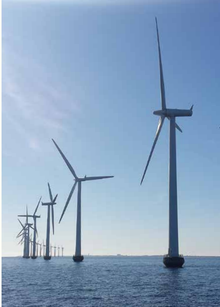
DANSK VINDKRAFT: Middelgrunden vindpark ved København. FOTO: CMR
